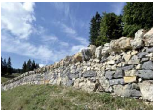
Mur en pierres sèches dans le Brassus.
