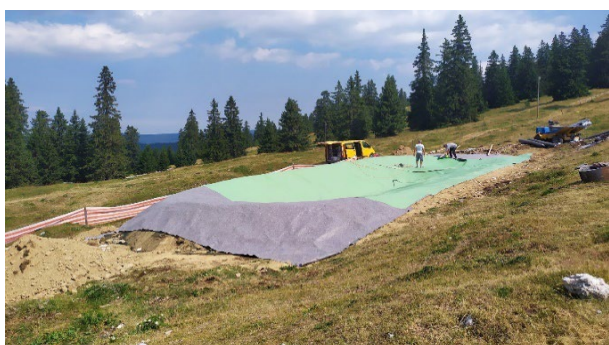
e. Imperméabilité (bâche entre deux géotextiles)
