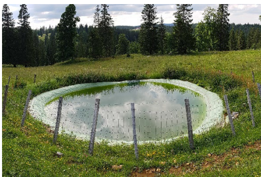
Figure 3. Bassin dont l'étanchéité est assurée par une bâche plastique nue (Le Mazel, Montricher, VD).
