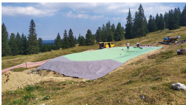
e. Imperméabilité (bâche entre deux géotextiles)
